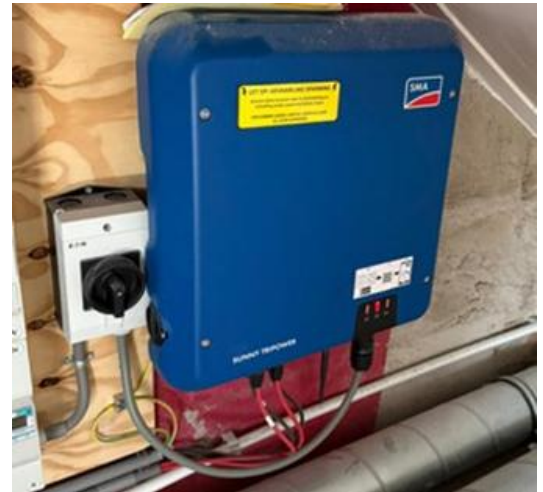
Omvormer zonnepanelen
