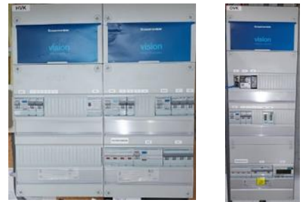
Groepenkasten HVK (links en OVK (rechts)
