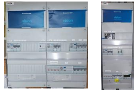
Groepenkasten HVK (links) en OVK (rechts)
