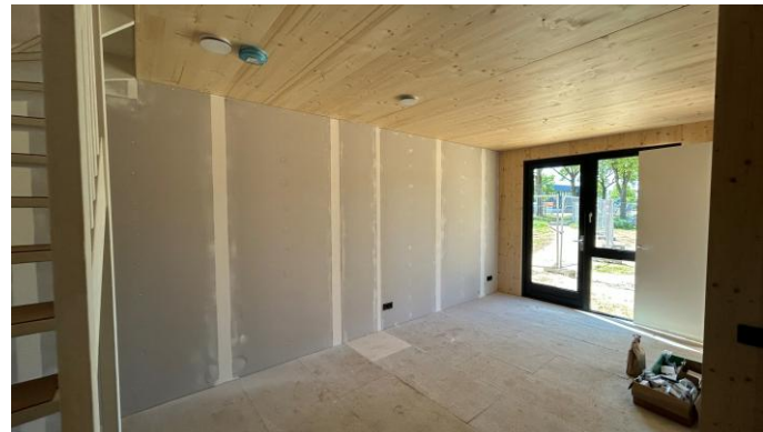
VOORBEELD WANDEN MET GIPSAFWERKING
