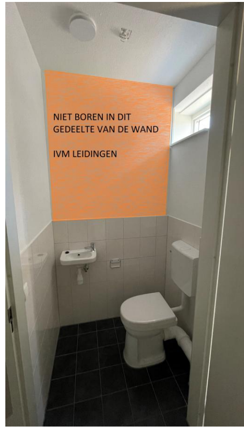
Figuur 4; wand toilet
