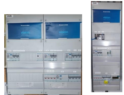
Groepenkasten HVK (links) en OVK (rechts)
