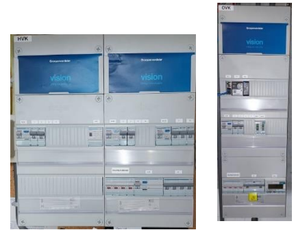
Groepenkasten HVK (links) en OVK (rechts)
