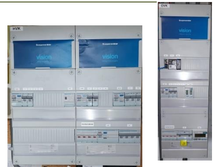
Groepenkasten HVK (links) en OVK (rechts)
