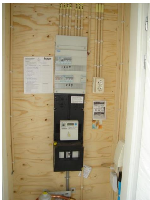
Completer meterkast
