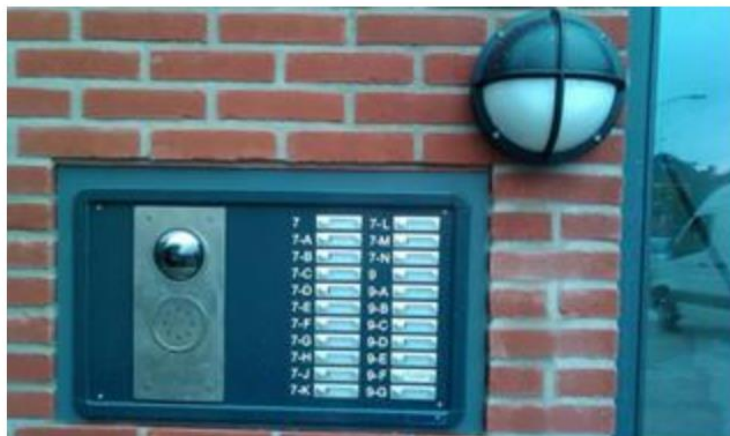
Deurtableau ter plaatse van de hoofdingang met video
