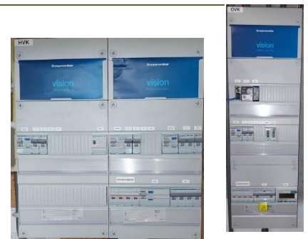
Groepenkasten HVK (links) en OVK (rechts)
