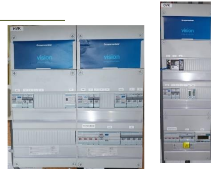
Groepenkasten HVK (links) en OVK (rechts)
