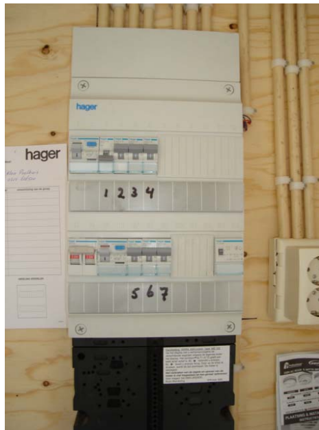
Groepenkast: in totaal 7 groepen verdeeld over 2 aardlekschakelaars.
